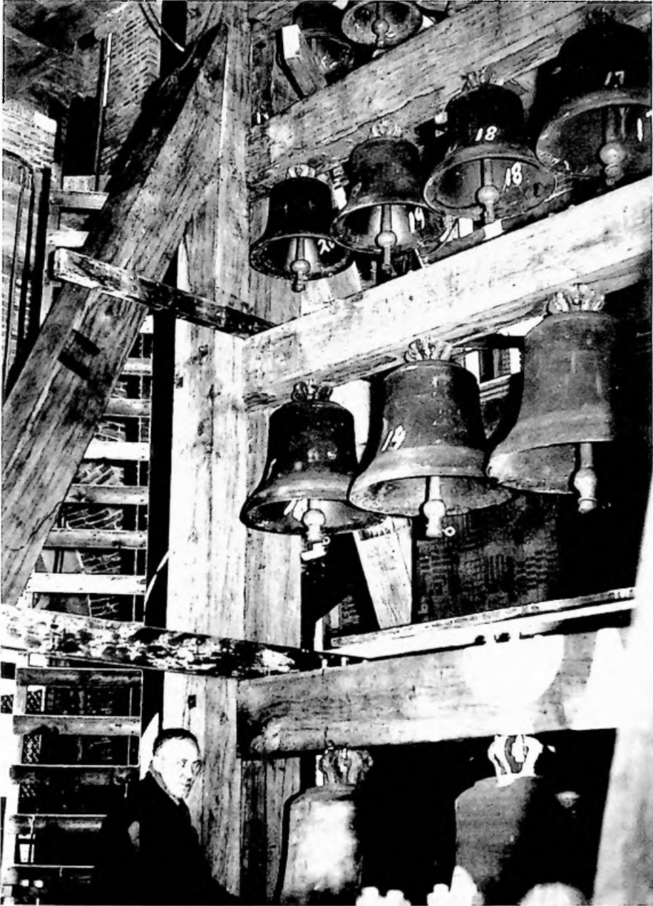
De nieuwe klokkenstoel in 1939. De klokken zijn al gemonteerd, maar de tractuur moet nog worden aangebracht. Foto Gemeentelijke Archiefdienst Rotterdam.
